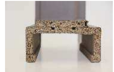
obložková zárubeň konstrukce SEPOS v řezu
